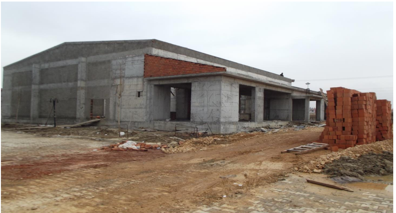
Merkez Atatürk Sağlık Meslek Lisesi Spor Salonu inşaatı devam etmektedir.
