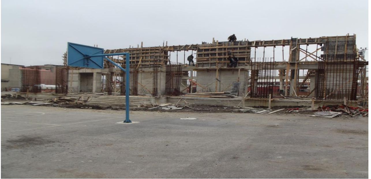
Merkez Osmangazi Anadolu Lisesi spor salonu inşaatı devam etmektedir
